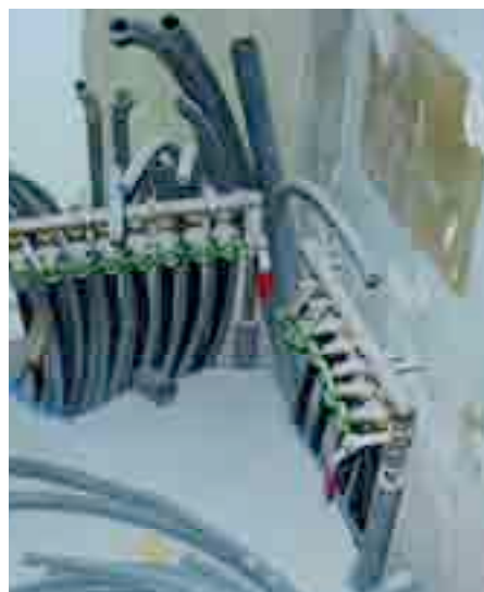
Einige Leitungen mussten verlegt werden ...
