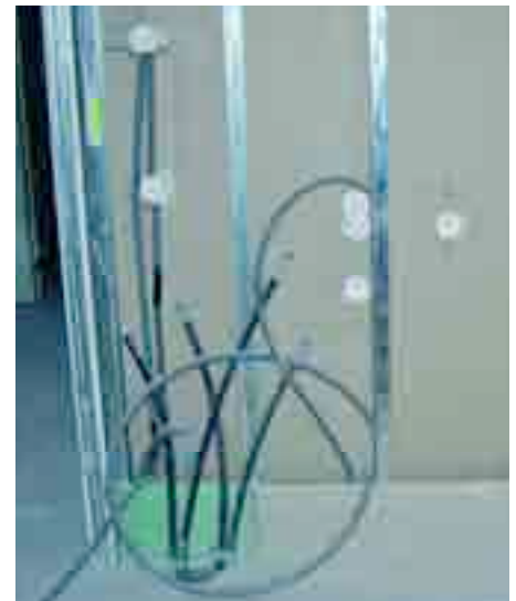
Die Anschlüsse mussten am richtigen Ort sein.
