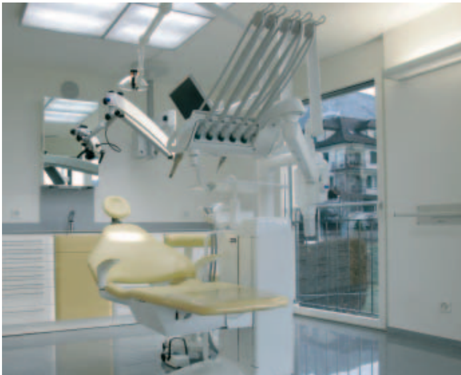
So sieht eine optimale Beleuchtung für ein Behandlungszimmer aus.
