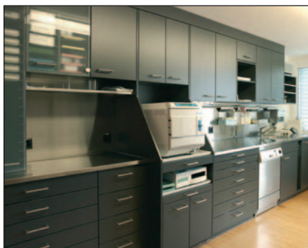
Nach dem Umbau: klar strukturierter Hygieneablauf.
